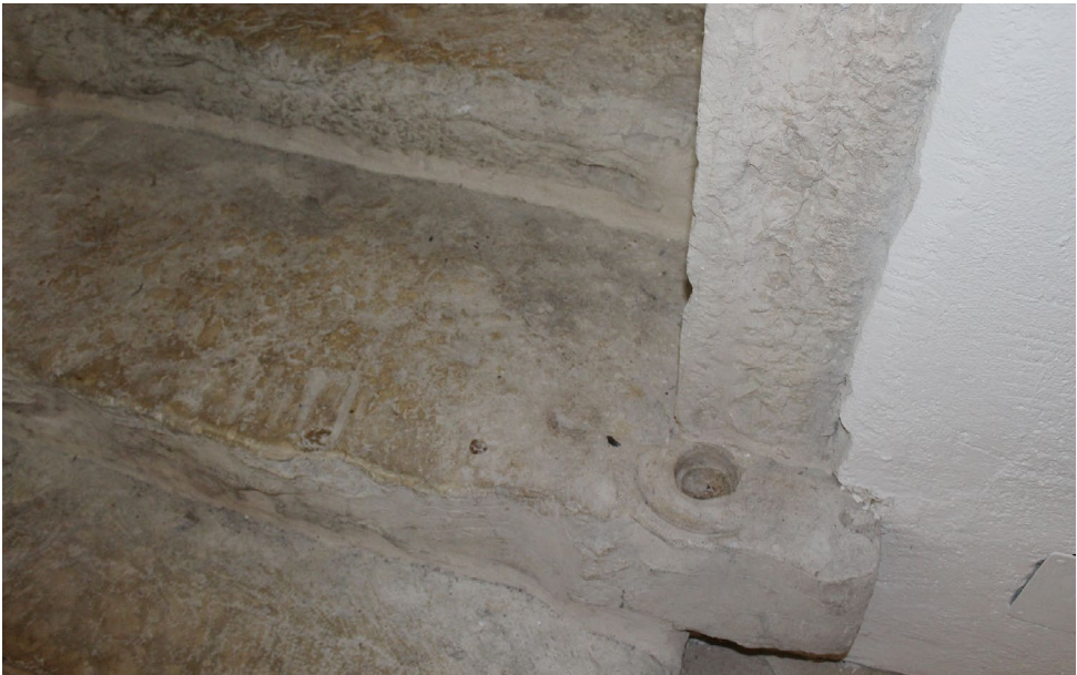
Abb. 33 Rovereto, Via della Terra, Centro socio-educativo Terra, Spur der ehem. Türangelei
