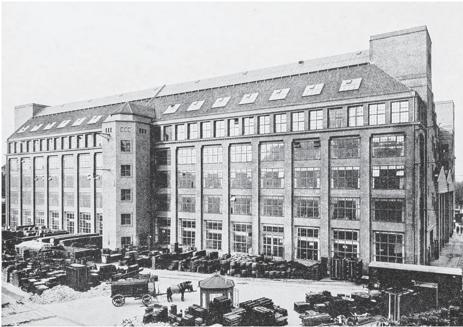
Abb. 4 Peter Behrens, Hochspannungsfabrik der AEG am Humboldthain in Berlin-Wedding, 1909/1910, Ansicht von Süden, Fotografie von unbekannt
